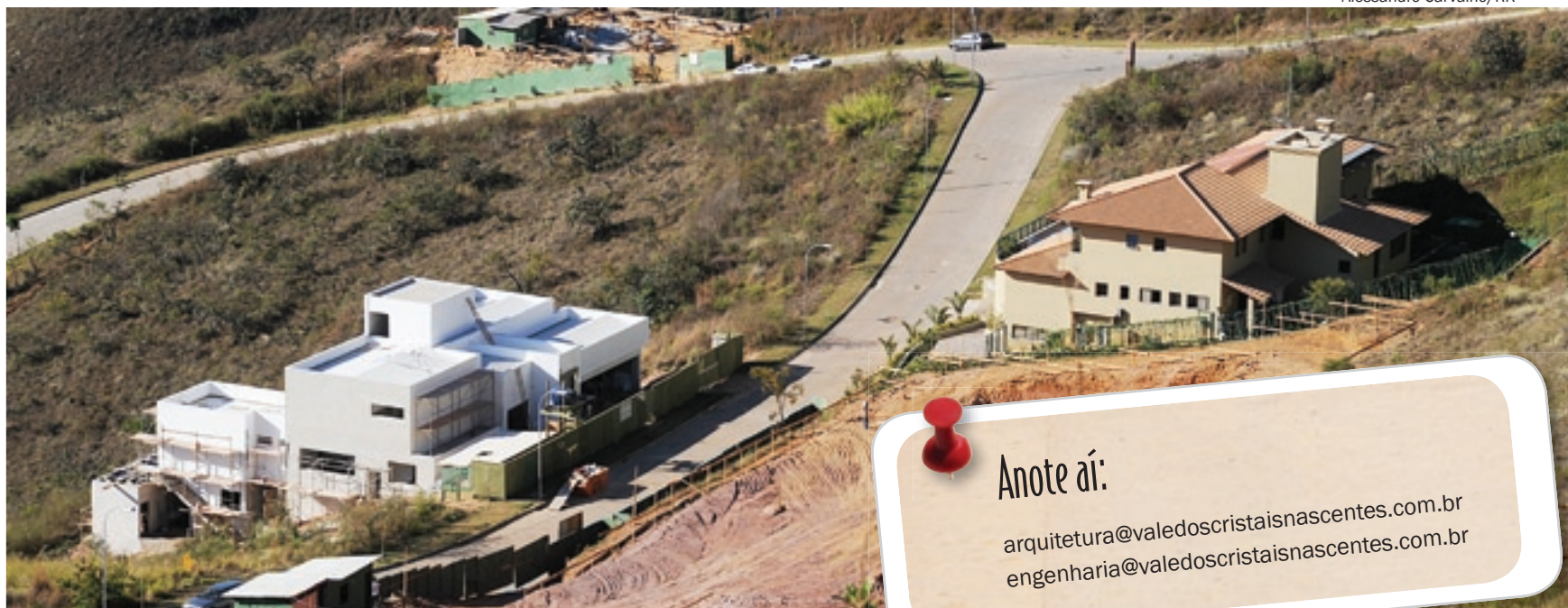
O Vale dos Cristais - Nascentes passa por fase de grande expansão
